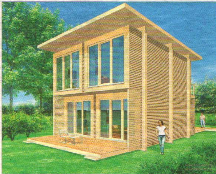
Ein Microhotel setzt sich aus stapelbaren Raumelementen zusammen, die zu beliebig großen Gebäudeeinheiten erweitert werden können. Hier sind vier Elemente zusammengestellt. FOTO: ZVG
